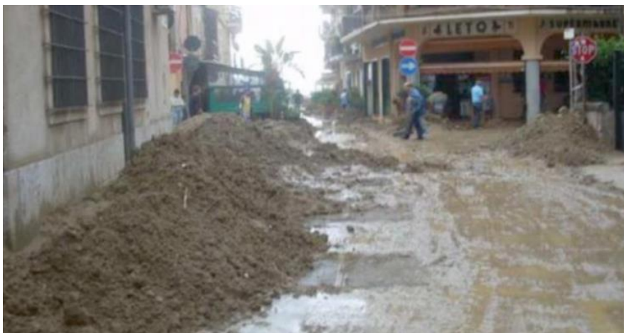
Figura 8 - Inondazione Torrente Papale
