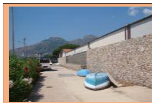
DOPO L' INTERVENTO
